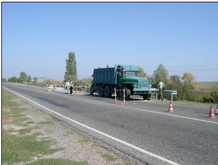
Pour la préparation de surface un camion de sablage mobile a été utilisé. Après sablage de l'ancienne galvanisation sur les glissières, le degré moyen de rugosité était de Rz 15 µm. L'épaisseur du film **ZINGA** par pistolet airless était de 90 µm.
