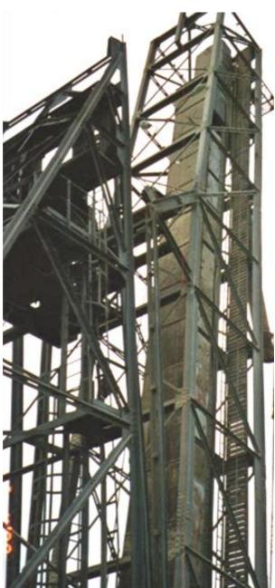
Puisque ces deux grues et leur passerelle de liaison étaient fortement corrodées, il a été décidé de les recouvrir par un système anticorrosion donnant une protection cathodique: le ZINGA a été choisi!!
