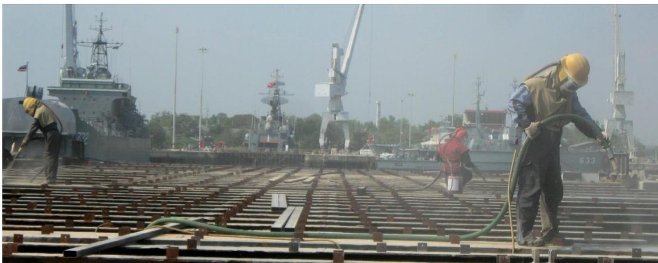
Ces rails sur le **chantier naval de la Marine** ont été protégées contre une corrosion importante (causée par l'emplacement des voies dans la zone de marnage) avec le système **ZINGA** unique.
