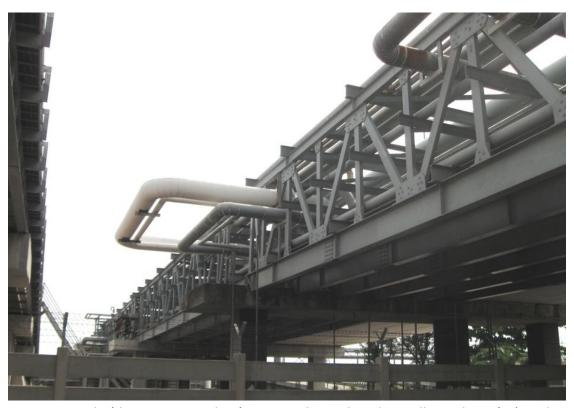
En 2009, **IRPC** a utilisé le **ZINGA** pour la réparation des taches de rouille sur la jetée (conduites de gaz et structures de support). Depuis lors environ 15.000 m² des 50.000 m² de structures ont été réparées avec du **ZINGA** et du **ZINGALUFER**.
