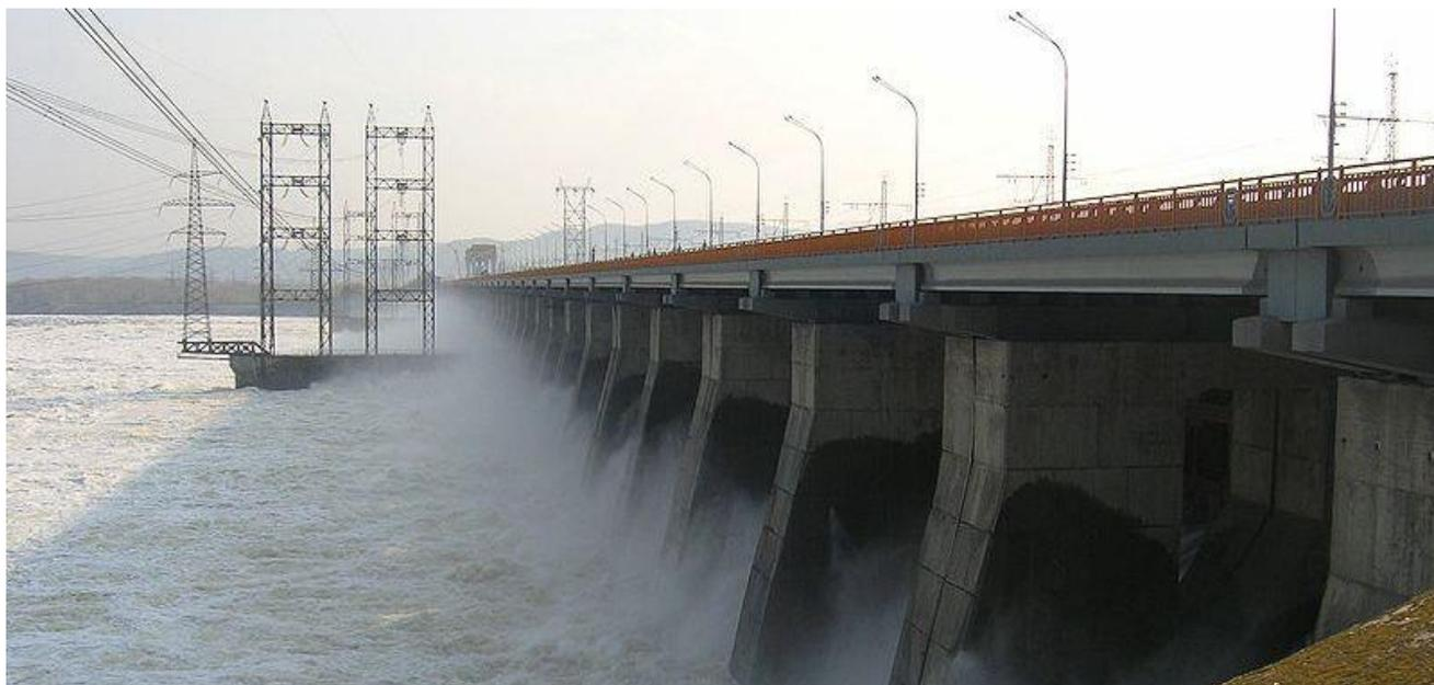
En 2011 les entretiens sur les valves de réglage de débordement ont débuté. Après nettoyage et après avoir rendu la surface rugueuse, **ZINGA** a été appliqué par pistolage avec un film d'épaisseur de 100 µm EFS.
