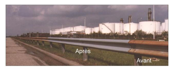
Système: Lavage à eau haute pression ZINGA 2 x 60 µm EFS
