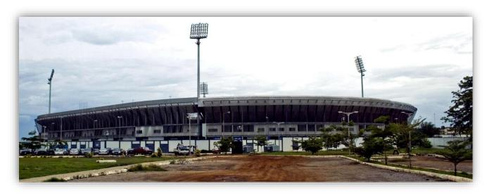
Les mâts d'éclairage sont des structures galvanisées à chaud avec une hauteur de 48 mètres et un périmètre de base de 4,5 mètres, érigées sur un support en béton. Les 4 mâts d'éclairage étaient sérieusement corrodés sur plusieurs niveaux.
