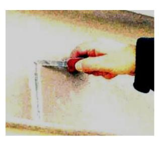
Op deze foto wordt het stof verwijderd en de intacte **ZINGA** laag wordt zichtbaar.
