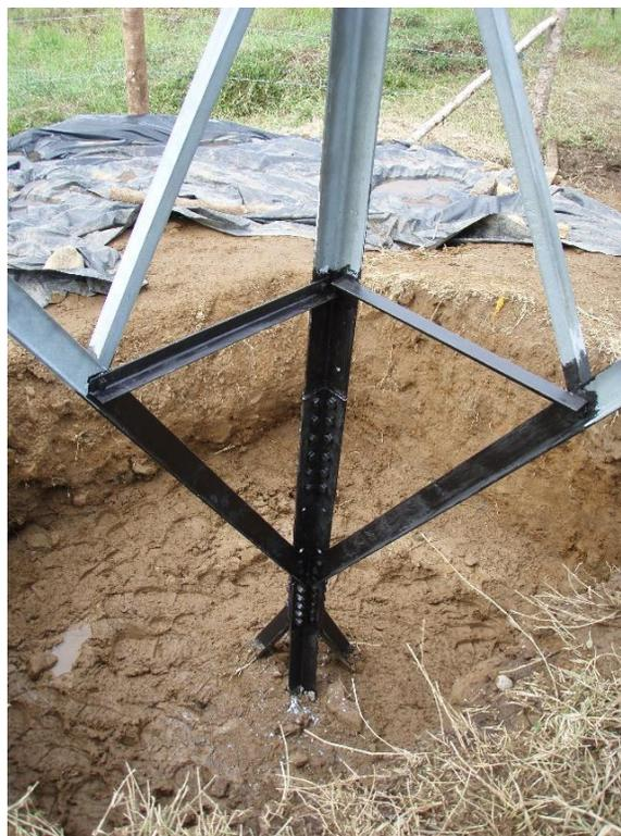
En 2009, ils avaient fait un essai en utilisant le **ZINGA** en système unique pour les parties au-dessus du sol et en système **ZINGA + ZINGATARFREE** pour les parties enterrées.
