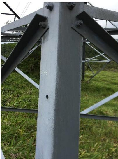
A ce jour, **ICE** utilise encore toujours le **ZINGA** pour l'entretien de ses pylônes à haute tension et ses antennes de transmission.
