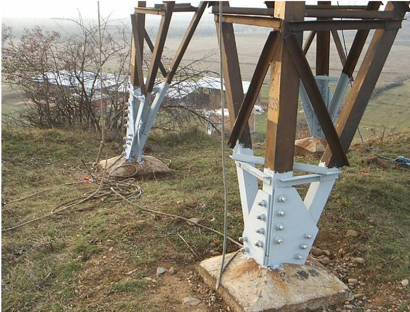
En février 2001 une première application d'essai a été exécutée sur une partie d'un pylône haute tension 110 kV dans la région de Targoviste (environnement très industriel, aggravé par la présence de SO<sub>2</sub>, Cl<sub>2</sub>, H<sub>2</sub>S, ...).
